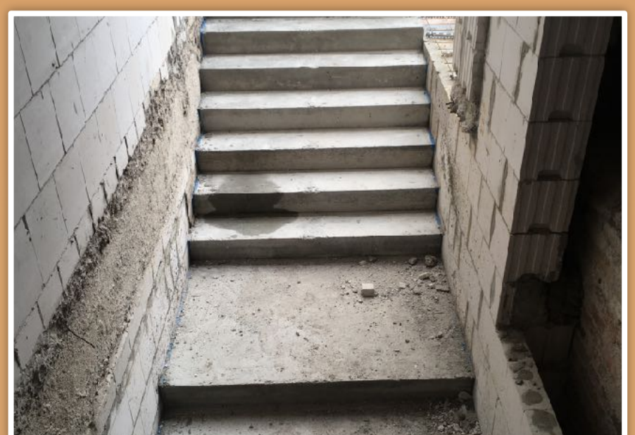
Und hier ist das neue Treppenhaus im Rohbau... (vgl. letzter Newsletter)
